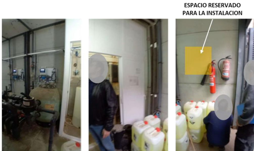
Figura 2. Replanteo de la instalación
