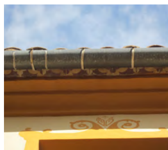
Tubo 3. Carrer de Canalejas, 4
