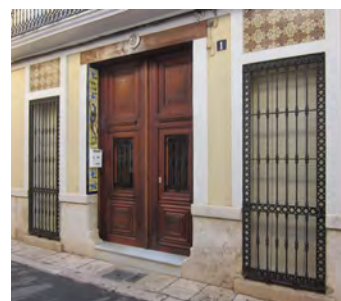
Tubo 4. Carrer de Canalejas, 3
